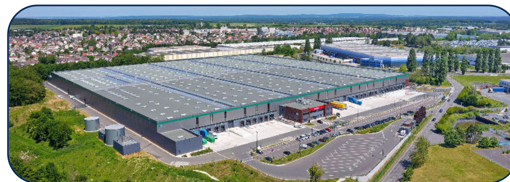
L'ancien site L'Oréal à Marly-la-Ville transformé par Prologis (2019).
